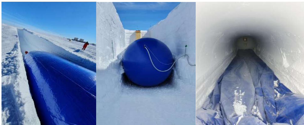
Figure 1 – Construction de la voûte de neige de la cave Ice Memory . Un ballon de trente-cinq mètres de long est inséré dans la tranchée puis gonflé, avant que de la neige ne soit fraisée sur le dessus. Une fois dégonflé, le ballon dévoile une voûte de neige. Source : Rocco Ascione, ENEA-UTA, Italy.
